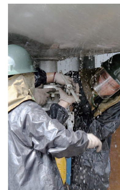
及时封堵漏点
