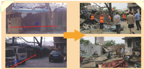
▲ 燃气管线隐患整改前后对比照片
